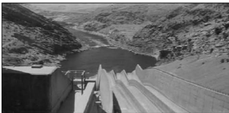
Earth Dam (16) figure سد تراپی صورة رقم (16) بهر به سقی خاکی شیوهی (16)
